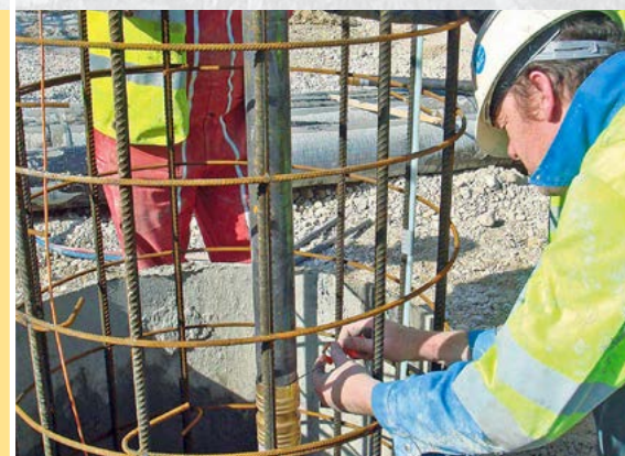
在桩内安装滑动测微计
