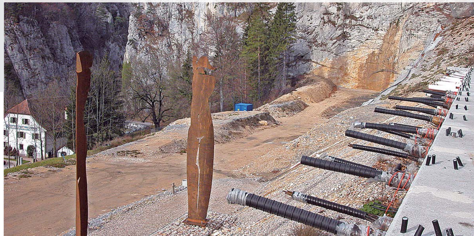
Canton Berne的Roches-Moutier部分施工, Transjura A16高速公路, 桩壁中进行三向位移计测量
