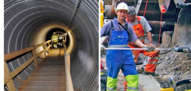
Canton Berne的Roches-Moutier部分施工, Transjura A16高速公路, 桩壁中进行三向位移计测量
