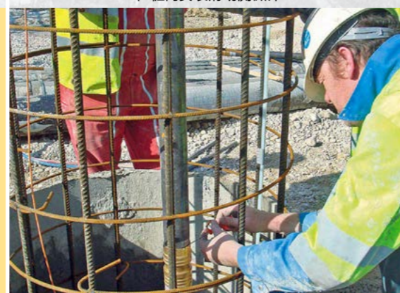
在桩内安装滑动测微计
